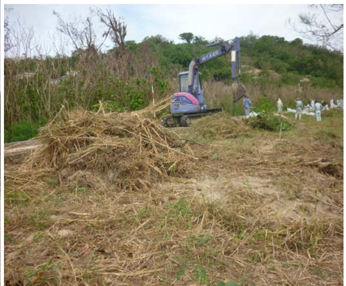
作業状況 浜辺の茶屋より奥武島方向
